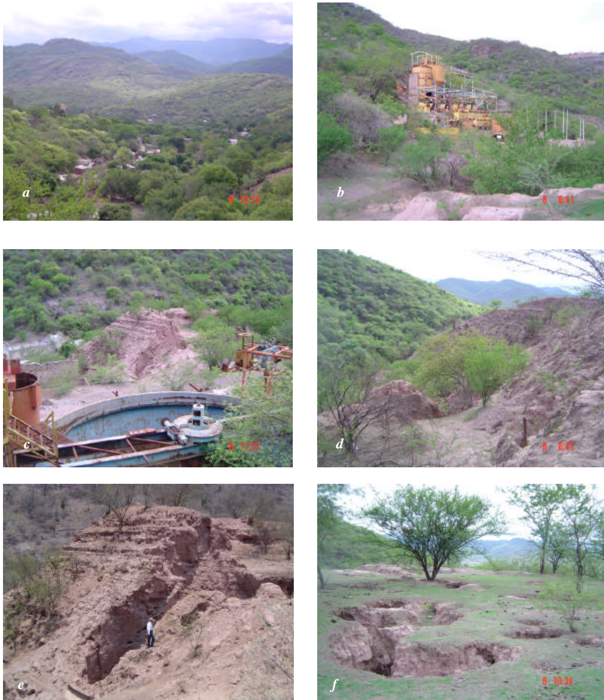
Figura 6. Situación general del sitio de estudio ubicado en Tlaquiltenango, Morelos. (a) panorama general del sitio; (b) planta de beneficio y jales; (c) tanque de flotación y montículo de jales; (d) montículo de jales (e) montículo de jales; (f) panorama de la superficie de uno de los montículos de jales.
